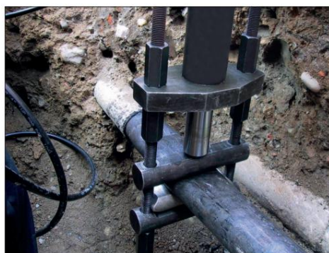
Pumpedrift til rørkomprimering
