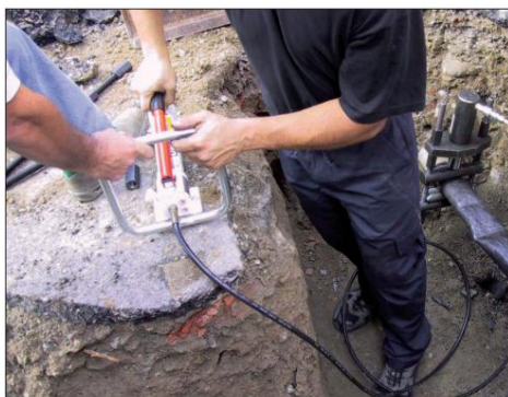
Pumpedrift til rørkomprimering
